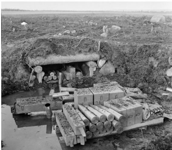
Värnet på 200 m avstånd hade rasat delvis.
