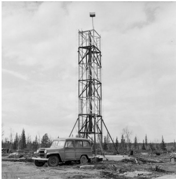
Centrumtornet och den intilliggande bunkern hade tidigare använts vid andra prov av KFF Robotbyrå. Centrumtornet försågs med åskledare.
