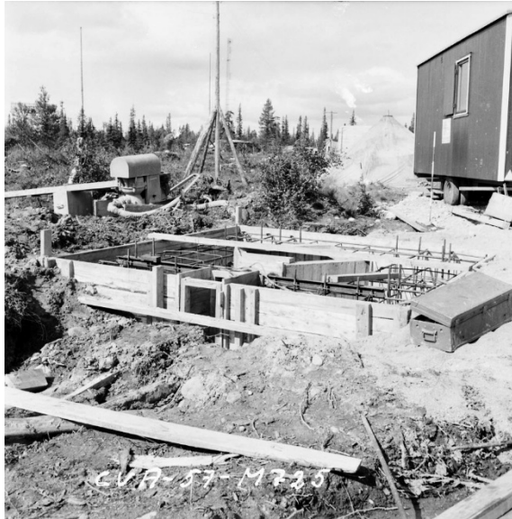
På 50 m avstånd från centrum utförde CVA-personal ett fundament för en 7,5 ton stålkupol.
