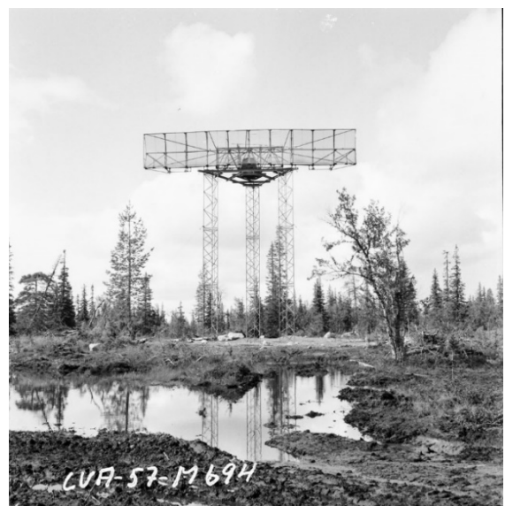
Trippelmasten var 12 m hög och hade en 14 m reflektor.
