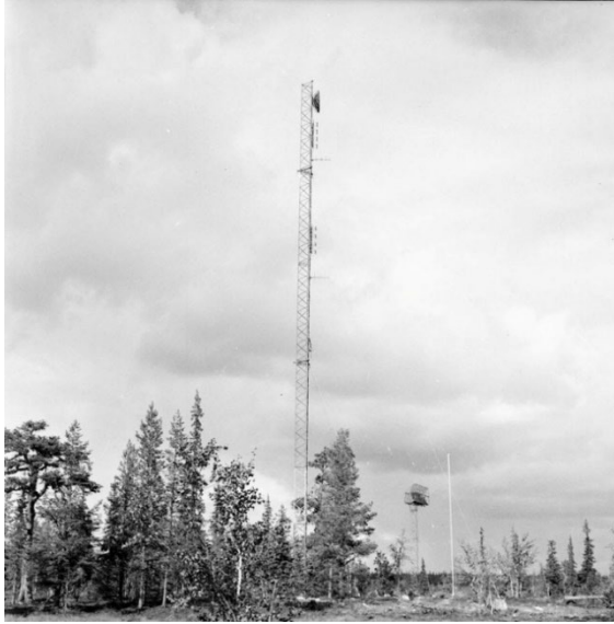
En 41 m hög triangelmast med olika typer av kablar och antenner restes på ett avstånd av 210 m
