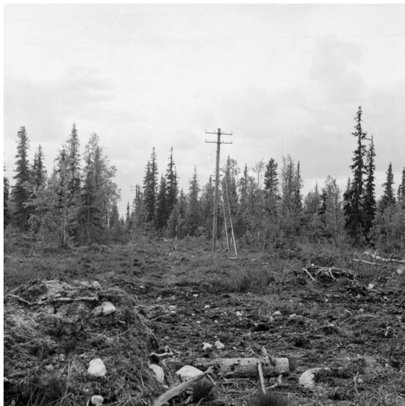
Televerket lät sätta upp ett blanktrådsstråk. Bilden visar stolpen närmast centrum på 50 m avstånd. På stolparna uppsatte sedan CVA koaxialkablar för KFF.
