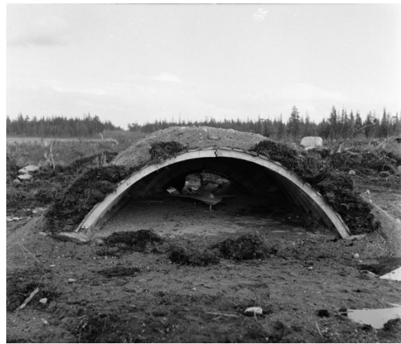
Fpl-värnet närmast centrum hade en del mindre skador. Fpl-modellerna hade flyttat sig.
