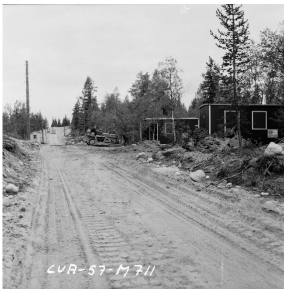
Förläggningssvagnar uppställda på kvartersplatsen. Expeditionstjänsten utfördes i kontorsvagnar
