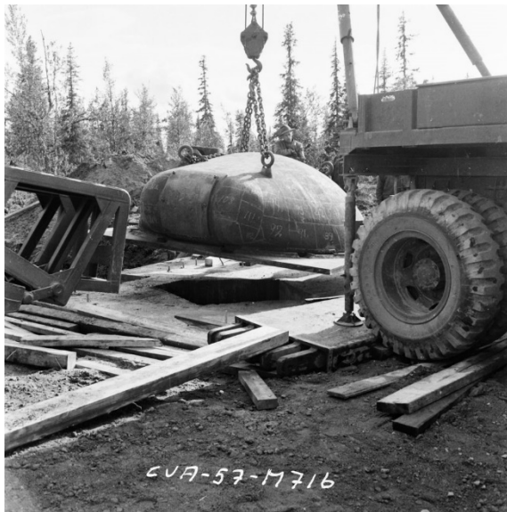
Lyftning från släpvagn till fundament utfördes av en kronbil.
