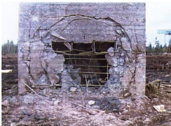
Smällarna gjordes för att mäta höga tryck. En bunker som byggts nära nollpunkten såg ut så här efteråt.
