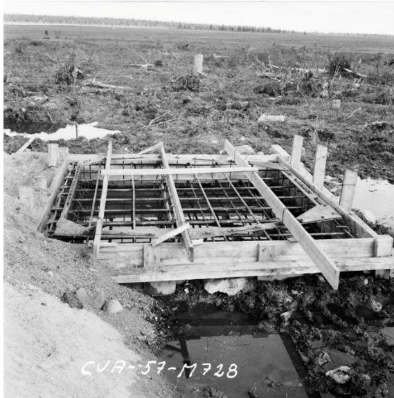
Fundament för 3 st plastkupoler på resp. 100, 200 och 300 m ingick i CVA uppdrag från KMF.
