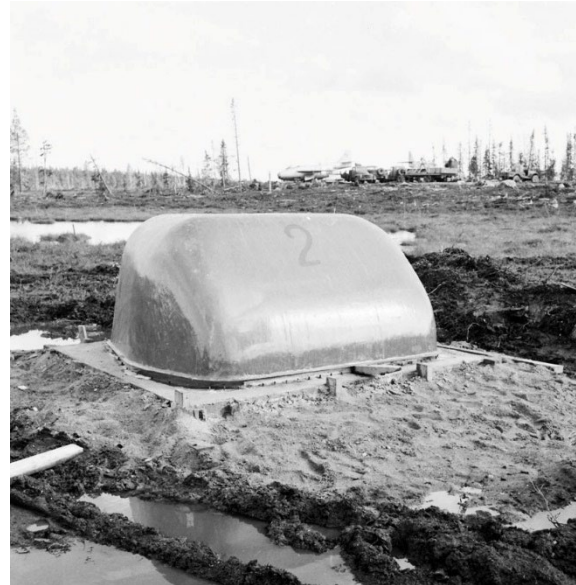
Kupol under montering på fundamentet.
