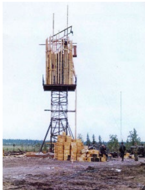
Kodnamnet Vega hade målats på den ammunition som skulle prövas i det hemliga försöket. I flygvapnets ombyggda tom travades tonvis med sprängämnen -tills tornet klagande knakade.50 ton var målet och det blev troligen 36 när lastningen avbröts.
