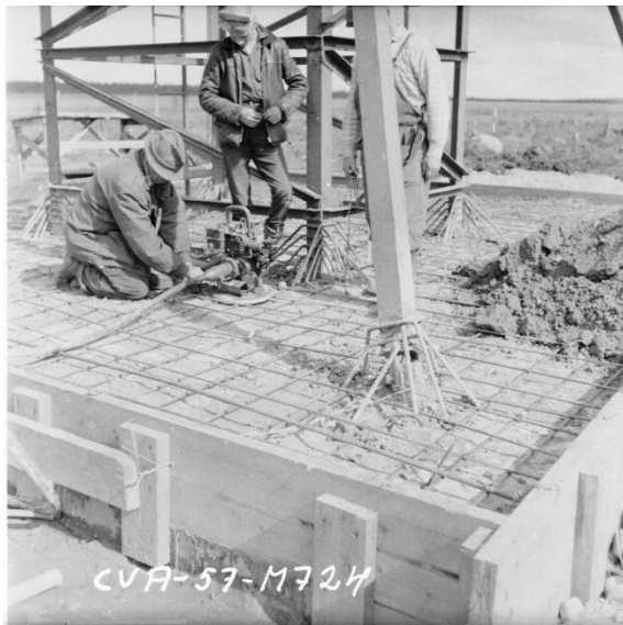
För FOA 2 fick CVA utföra en 7 x 7 m stor, kraftigt armerad betongplatta under centrumtornet
