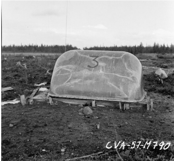
På plastkupolerna hade sprickor uppstått.
