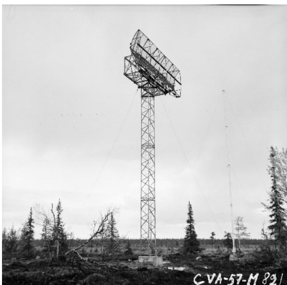
Radarmasten var försedd med stag och liknade en roterande mast.
