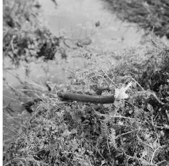
Ett splitter har skurit av en kabel RG-17/U
