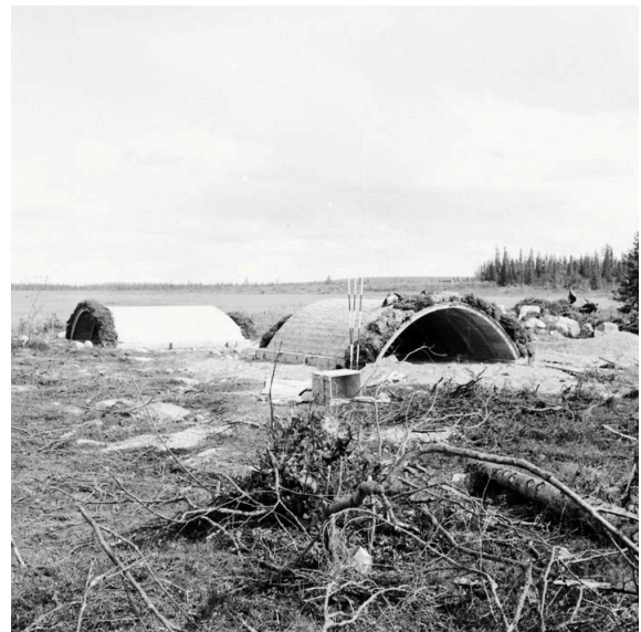
Värnen på 400 m från centrum. Värnens väggar och tak täcktes senare med grus
