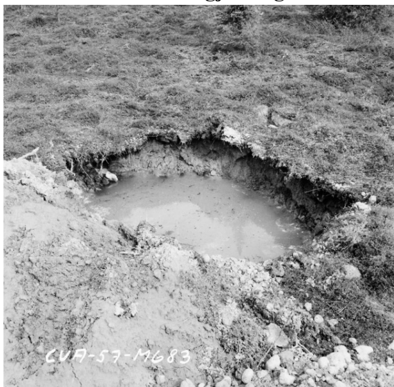
Grundvattennivån var endast någon decimeter under markytan. Uppgrävda hål vattenfylldes därför snabbt.
