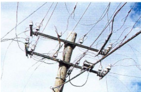
Efter den stora smällen. Telefontrådarna, som bara var 75 m från nollpunkten, hänger som ledsna serpentiner från lutande stolpar och träden knäcktes rakt av mitt på stammen. I ett av de projekt som följde på Nausta studerades vilken verkan ett kärnvapenkrig skulle ha på den svenska skogen.
