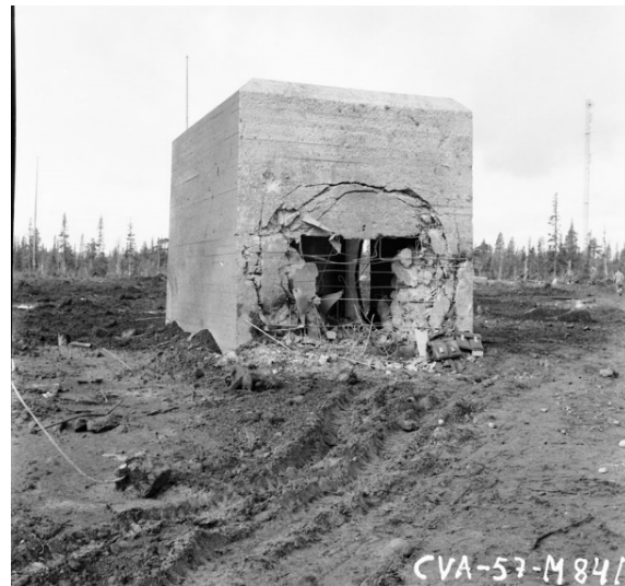
Bunkern 15 m från centrum hade svåra skador, 20 försöksdjur, kaniner, hade varit utplacerade på försöksplatsen.
