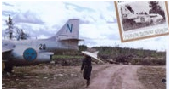
Till och med flygplan (om än ej i flygdugligt skick) hade dragits upp till Nausta. Det infällda tidningsklippet visar hur militärerna lurade pressen. De påstådda bärgningsövningarna var betydligt känsligare saker. Draken hade detta år 1957, bara varit i luften i två år och något riktigt flygplan fick man inte öva på. Det fick duga med modeller.
