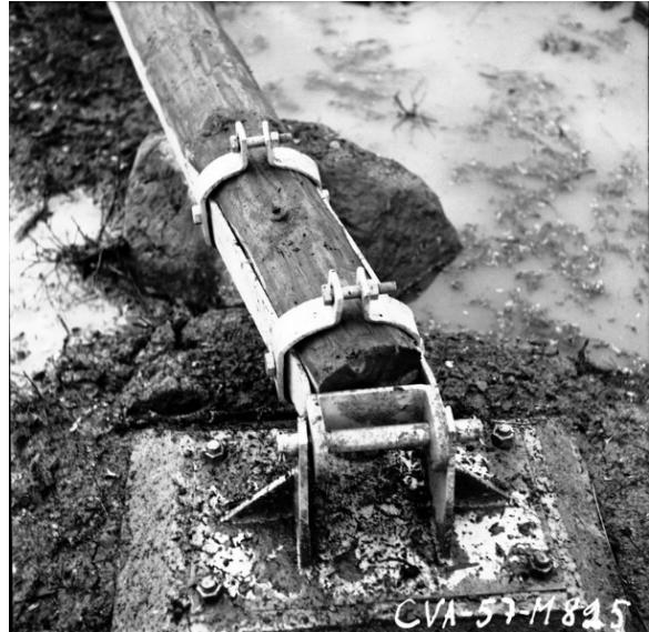
Trämast typ Tsn hade fallit troligen pga splitterskada på ett stag.
