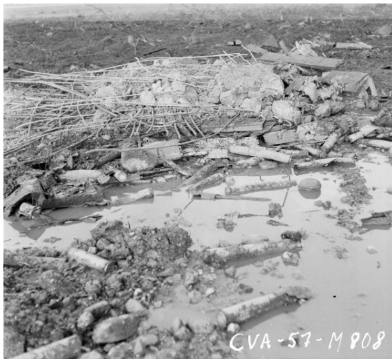
Armeringen i tornets bottenplatta låg i fyra högar 15 m från sin ursprungliga plats.
