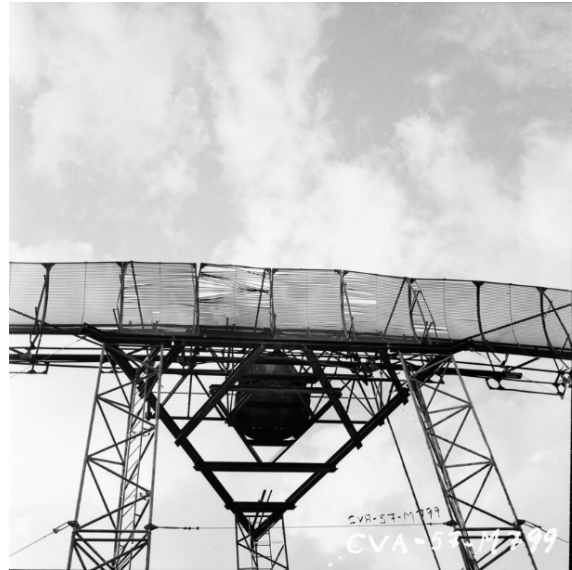
Skarvarna var uppslitna i radarreflektorn.
