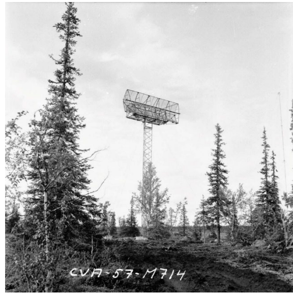
En 12 m hög radarmast med 8 m reflektor uppsattes på 210 m avstånd från centrum.
