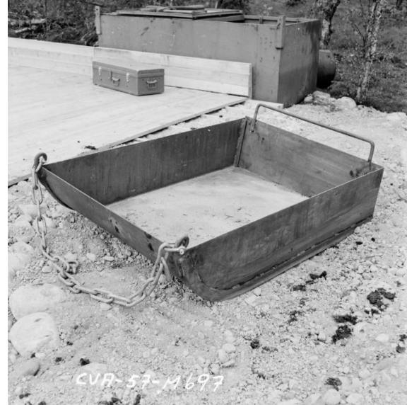
Enär betonggrus inte fanns på närmare avstånd än 7 mil, beställdes färdig betong från en cementvarufabrik i Jokkmokk. Betongsläpor och betonglave fick tillverkas. Släporna drogs av traktorer ut till gjutplatsen. Vatten fick köras i tunnor 12 km.
