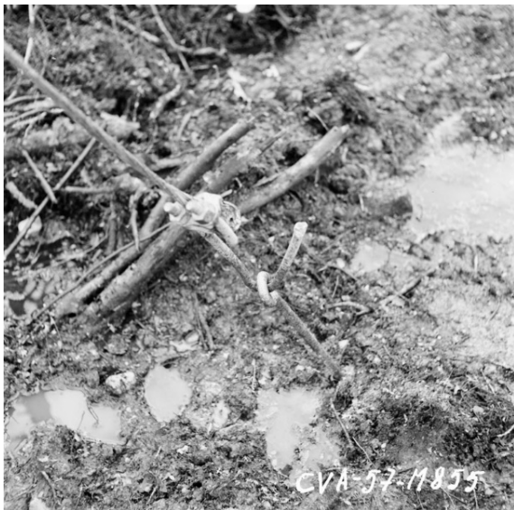
Stagskruv hade skadats av splitter.
