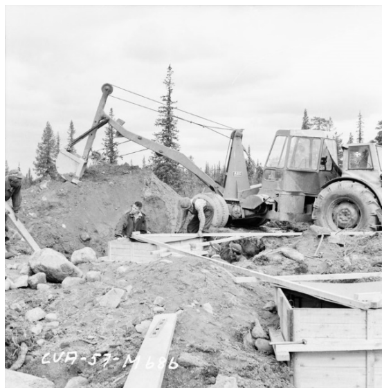
Traktorgrävs kopan hade arbete i 10 dagar mot beräknat 3.
