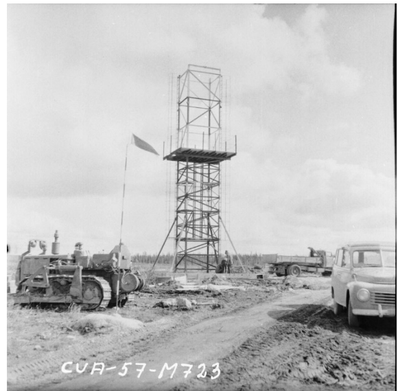
Tornet hade försetts med en plattform för sprängämnet
