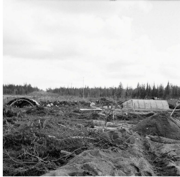
Fpl-värn i betong i skala 1:7 byggdes av personal från F21. Här en bild av värnen på 200 m från centrum.
